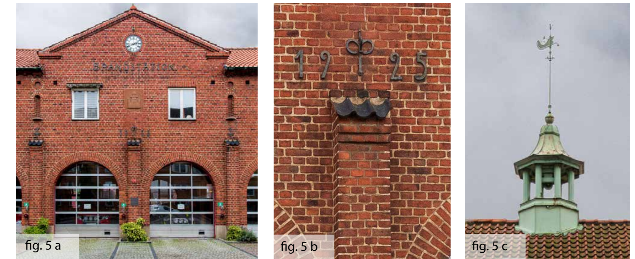
Fig. 5 - q. Skyddsbestämmelser för brandstationen anger att den röda tegelfasaden i sin helhet ska bevaras (fig. 5 a och 5 b) liksom ankarjärn (fig. 5 b), takryttare med spira och flöjel (fig. 5 c), takgesims (fig. 5 a), frontepis, emblem, portöppningar (fig. 5 a) och stråvpelare (fig. 5 a och 5 b) årtal (fig. 5 b) text och klocka (fig. 5 a).
