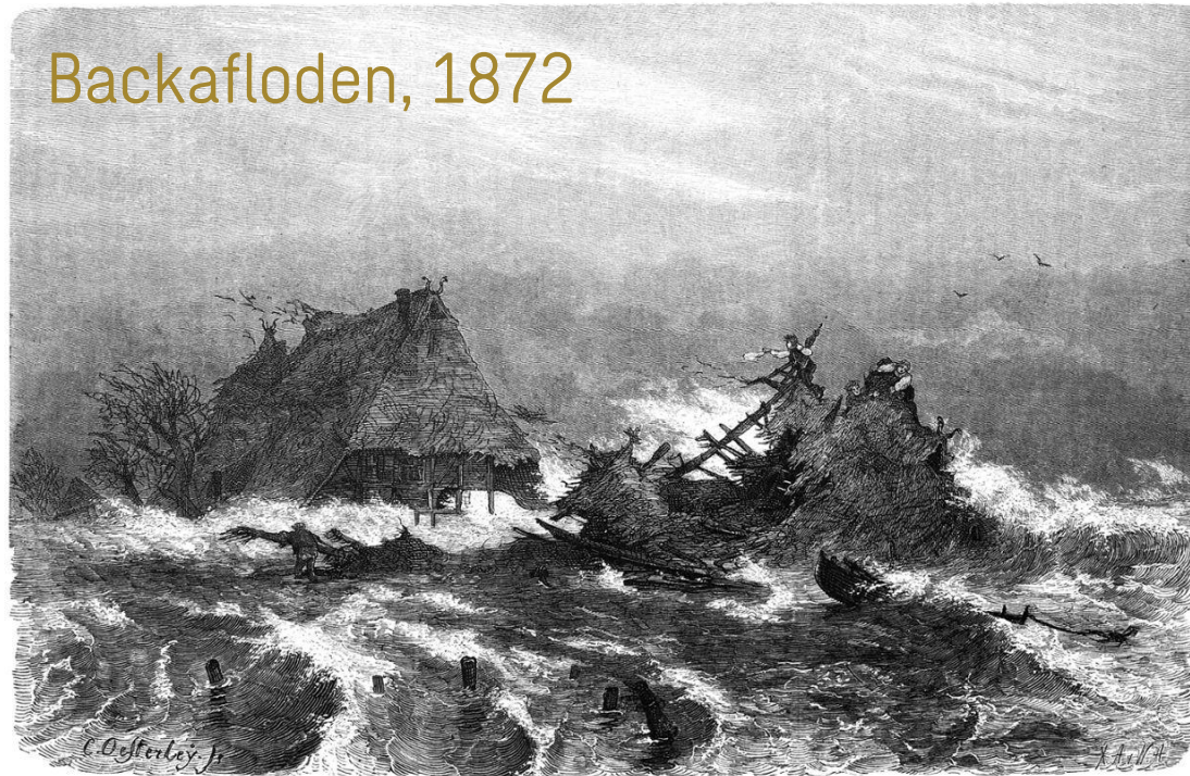
Der Zusammensturz eines Bauernhauses in Neuborf. Originalzeichnung von C. Oesterley.
