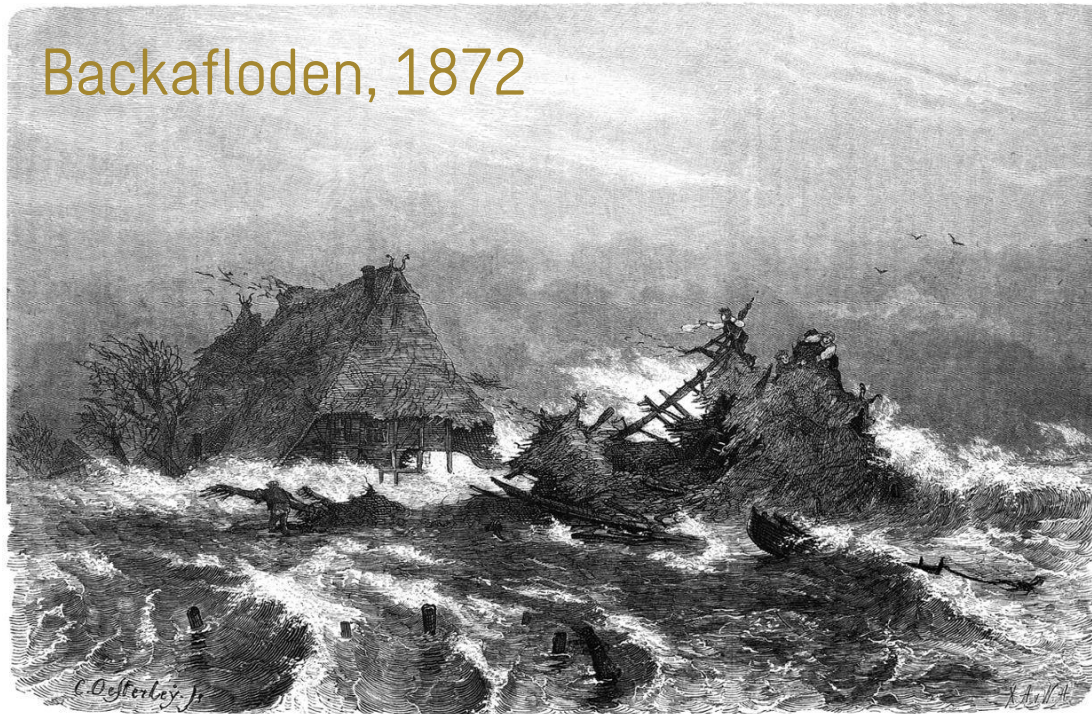
Der Zusammensturz eines Bauernhauses in Neudorf. Originalzeichnung von G. Defertley.
