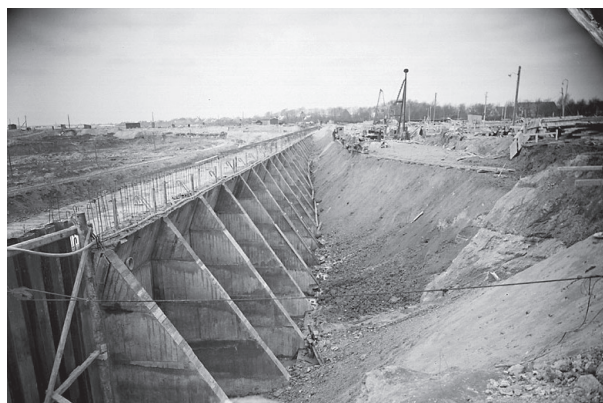
Uppförande av kajkonstruktion vid handelskajen, 1950-60-tal
