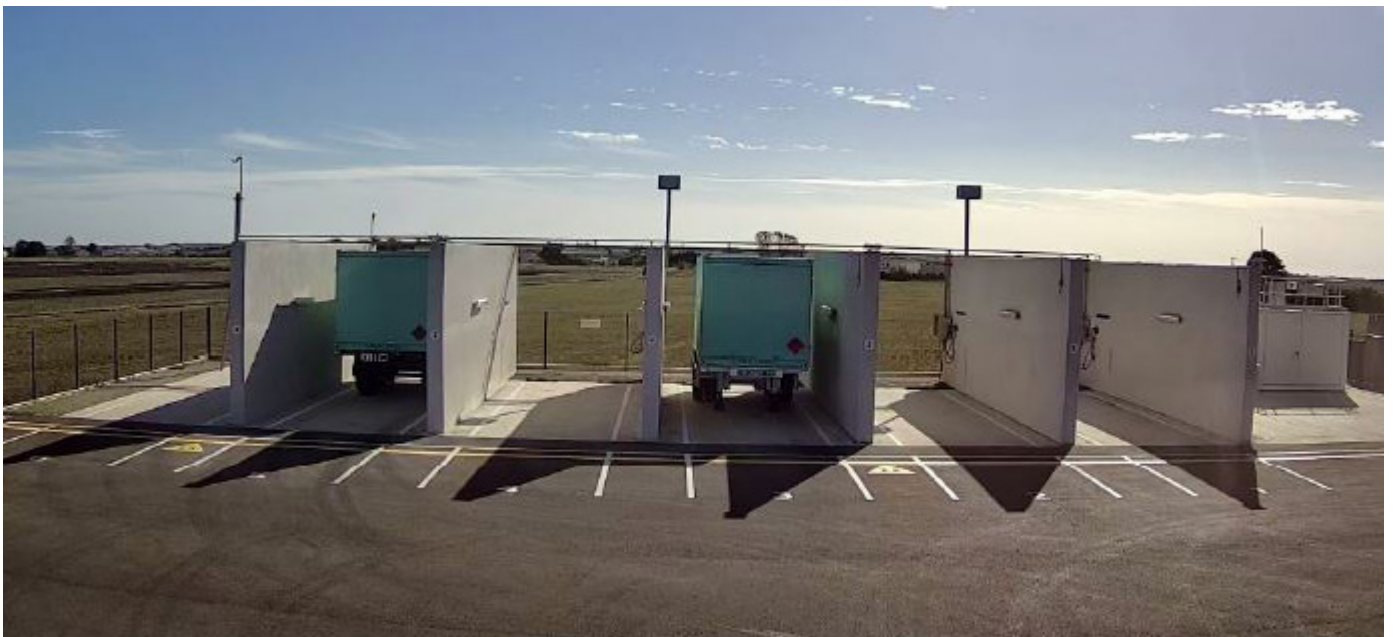
Anläggning i Bouin, Frankrike. Exempel på avskiljande betongmurar.
