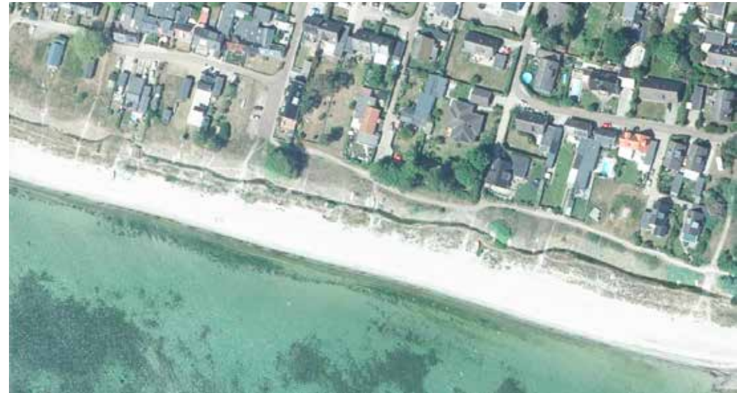
Illustration av markhöjning i form av förstärkning av befintliga sanddyner i Östra stranden.
