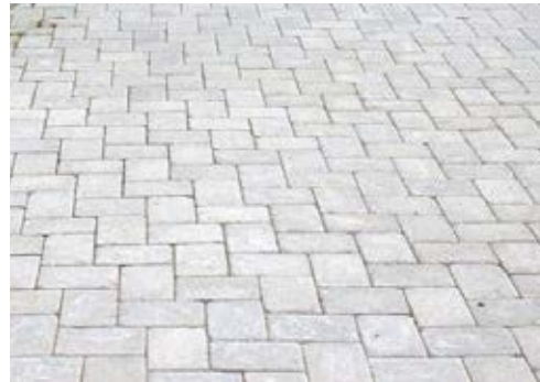
Betongmarksten i fiskbensmönster ger en tålig yta som klarar områdets trafik
