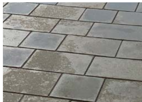
Betongplattor med genomgående fogar
