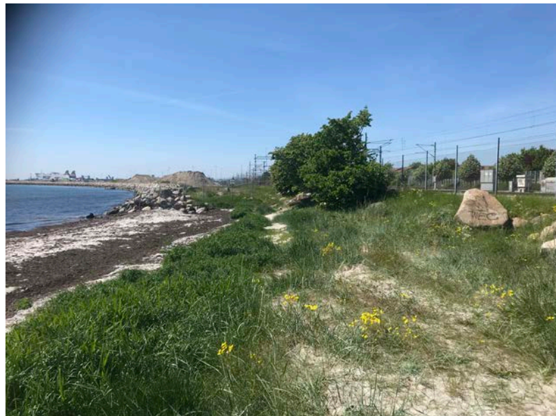
Yta för utökat erosionskydd. Befintlig skydd syns till vänster i bild
