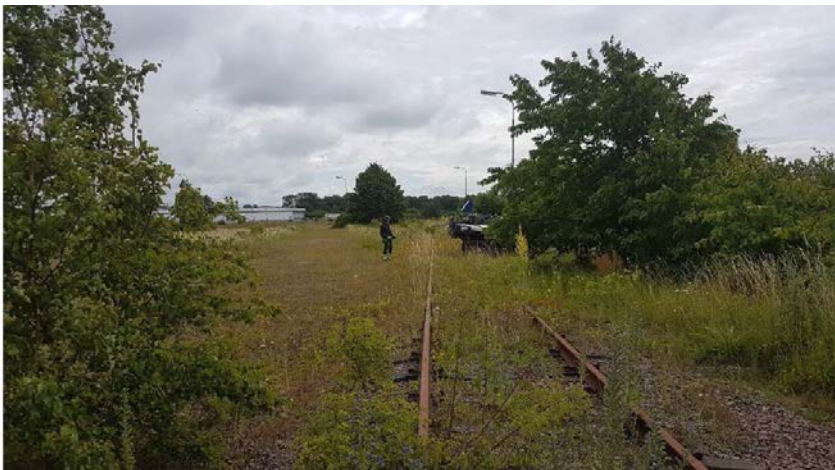
Del av befintligt spårområde som skall avvecklas
