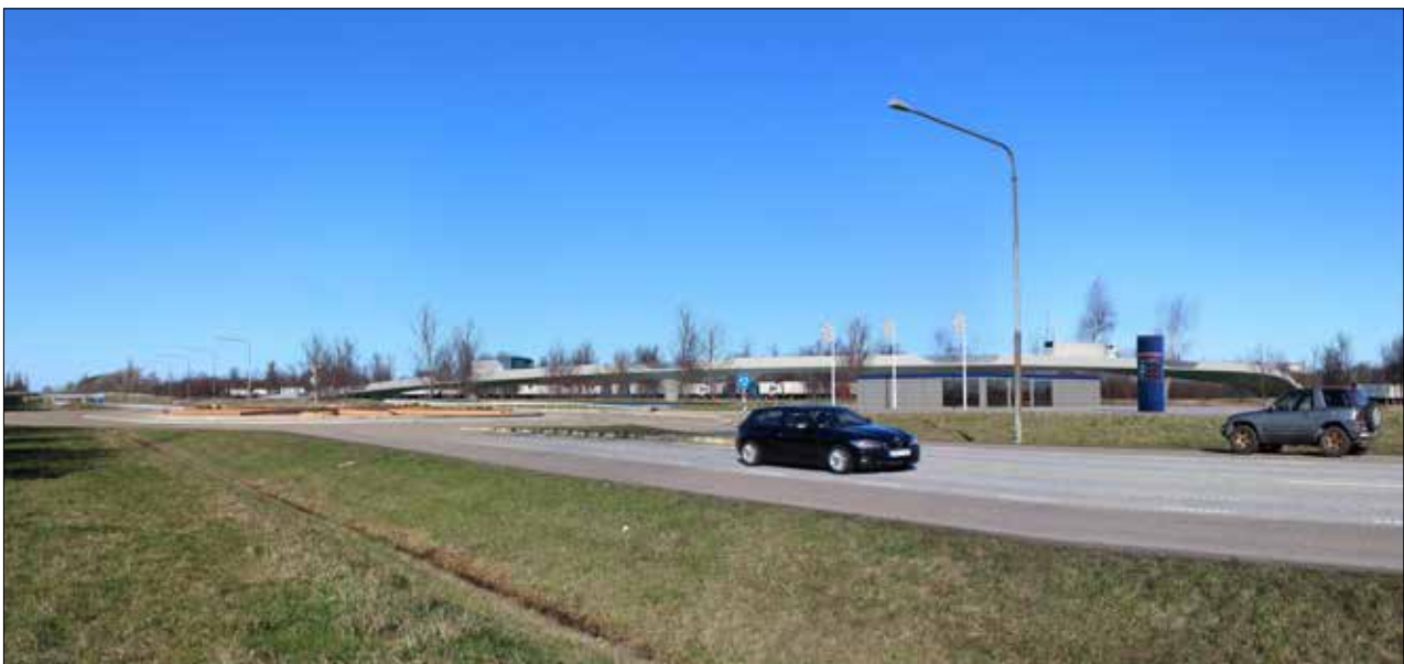
Visualiseringen som visar hur uppställningsytorna med framförvarande "flyover" kan komma att se ut i framtiden. Bild från riksväg 9.
